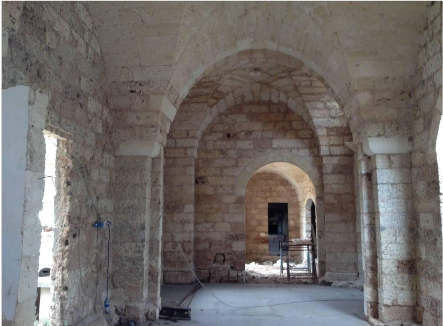
Integrazione/ricostruzione dei pilastri e formazione di architravi utilizzando vecchi conci tufacei recuperati in loco
